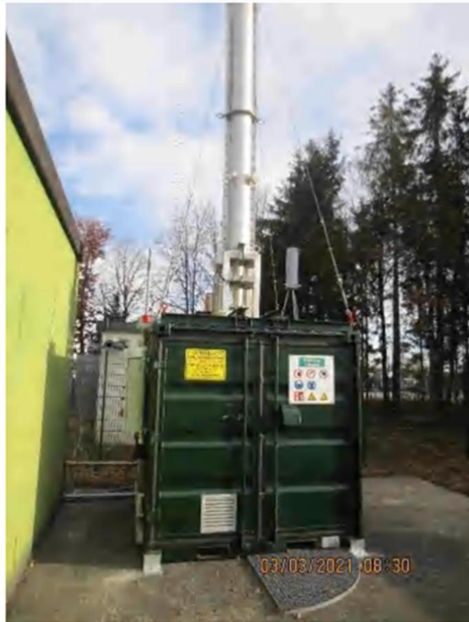
**Abbildung 5 Schwachgasanlage in Containerbauweise**
