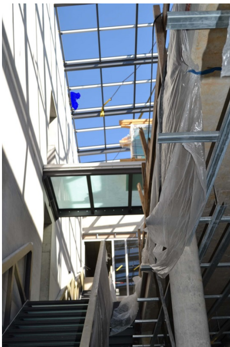
Bildunterschrift: So sieht die Dachkonstruktion von innen aus.
