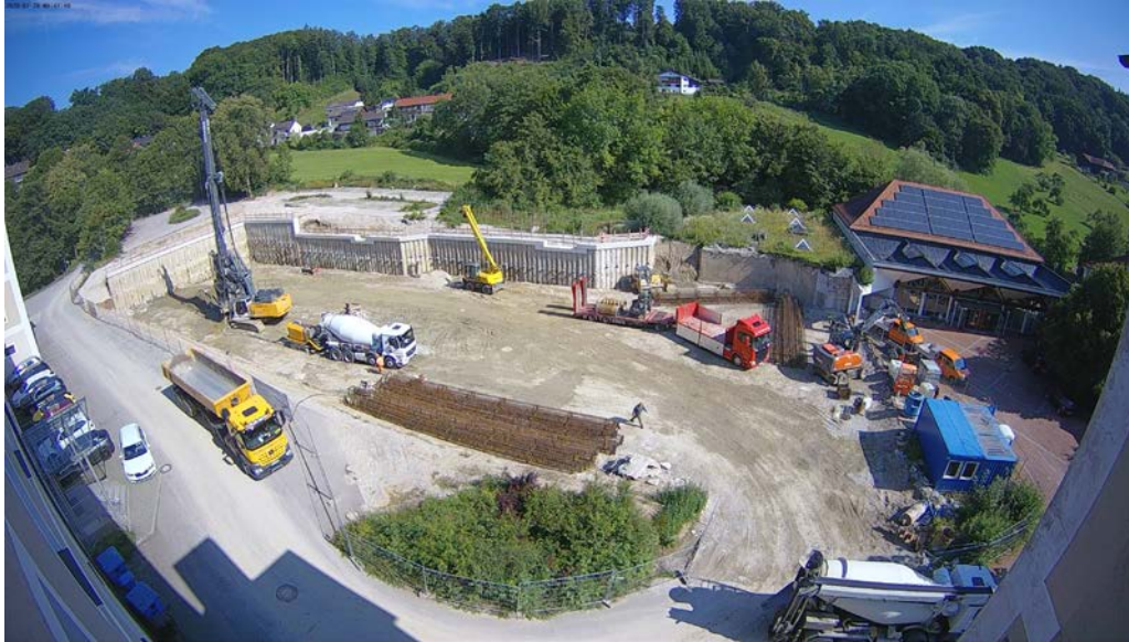
Bildunterschrift: Spezialtiefbauarbeiten beim Neubau des Gymnasiums Gars
