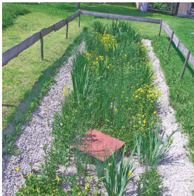
Abb. 5: Umzäunter bepflanzter Bodenfilter
