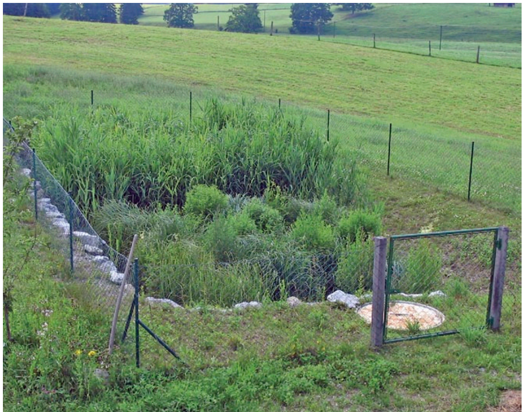
Abb. 6: Umzäunter bepflanzter Bodenfilter
